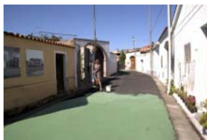
FIGURA 3. Dopo i lavori
