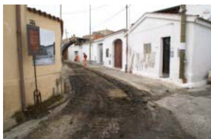
FIGURA 2. Prima dei lavori
